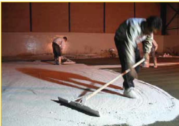
Vand Flooring Hardner، سخت کننده کف، ترکیبی بر پایه سیمان، سنگدانه های کوارتز سیلیسی (با مقاومت بالا) با دانه بندی ویژه و سایر افزودنی ها می باشد که در ضخامت کم و به صورت پوششی مقاوم بر روی سطح بتن تازه استقرار یافته اجرا می شود که در انواع کف سازی ها مصرف دارد و باعث افزایش مقاومت های مکانیکی و سایشی سطوح بتنی می شود.
